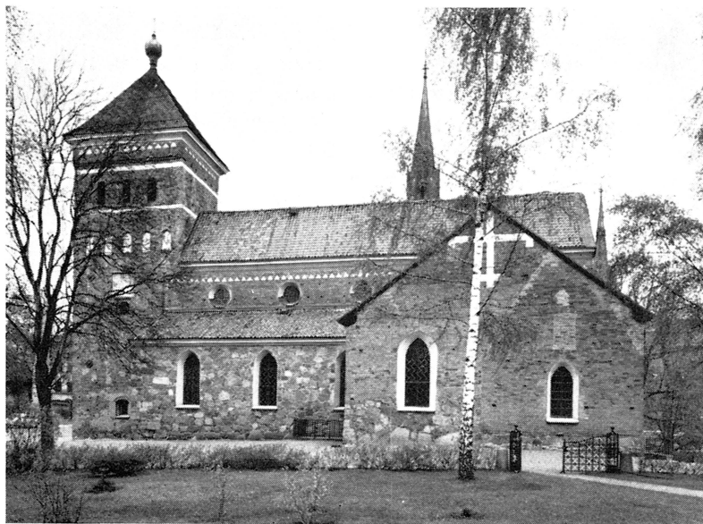
Bild 43. Trefaldighetskyrkan i Uppsala, sydfasaden. Kyrkans långhusarkitektur torde stå Uppsala domkyrkas primära långhus nära. Foto E. SKIRGÅRD, 1960.
