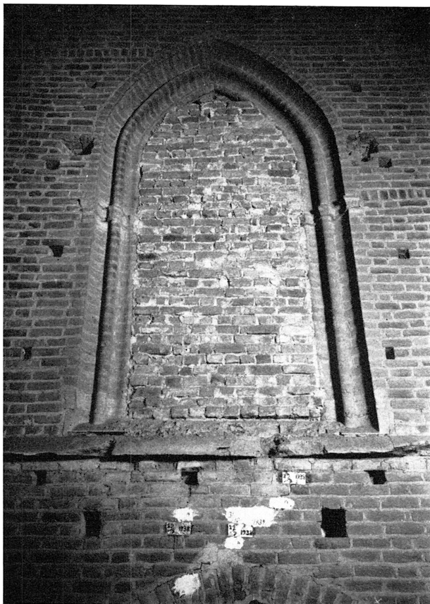
Bild 10. Västligaste kleristoriefönstret å södra långhusfasaden, nu dolt av södra tornet; fönstrets västligaste del skyntar å bild 9. Foto 1943.
