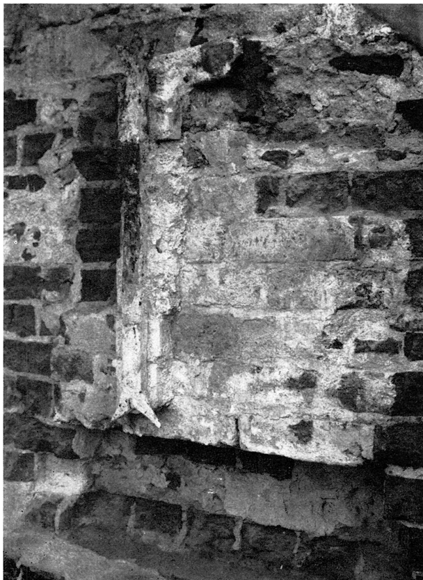
Bild 15. Ankarjärn från den högmedeltida stabiliseringen av högmurarna, frilagt å tryckpunkt å mittskeppets högmur å långhusets sydsida. Ankarjärnet, vars nedre del är tudelad, krönes av tre »hullingar», liknande en krona av enkel art. Foto 5 okt. 1942.
