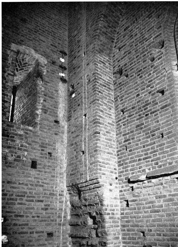
Bild 9. Kleristoriemurens sydsida vid västligaste travén; i bildens mitt den ursprungliga förkroppningen av västgaveln före tornbygget; t.v. södra tornets västmurs insida; t.h. skymtar det västligaste kleristoriefönstret och längst ner kalkstensdropplisten till vattentaket över sidoskeppen, linjerande med övre partiet till det sår, som uppkom då västgavelns vattentaksupplag bortbilades vid tornbygget under 1400-talet. Foto 1943.
