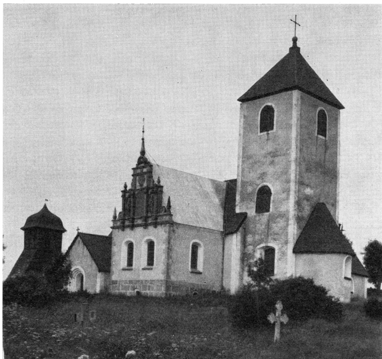
Bild. 1. Norrsunda kyrka. Mellan torn och vapenhus det Sparreska gravkoret med dess rika gavelröste i sandsten.
